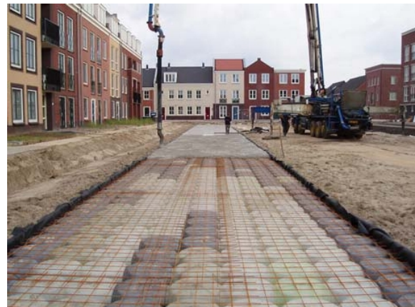
Betondek wordt gestort en verdicht..
