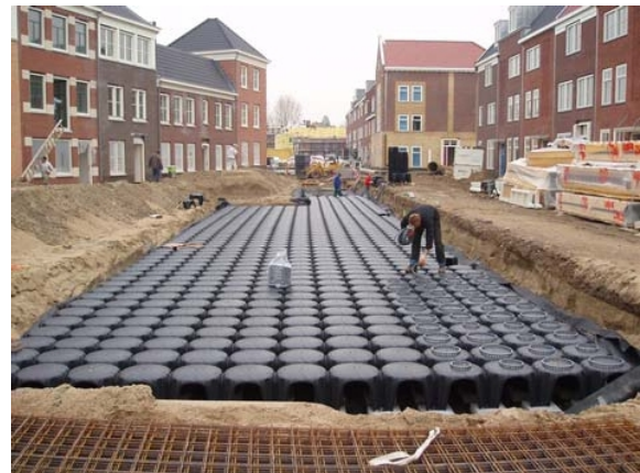
Aanbrengen van afstandhouders.
