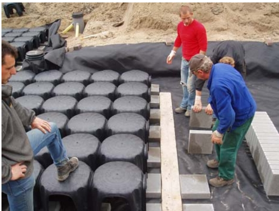
Aanbrengen van tegels op het geotextiel.
