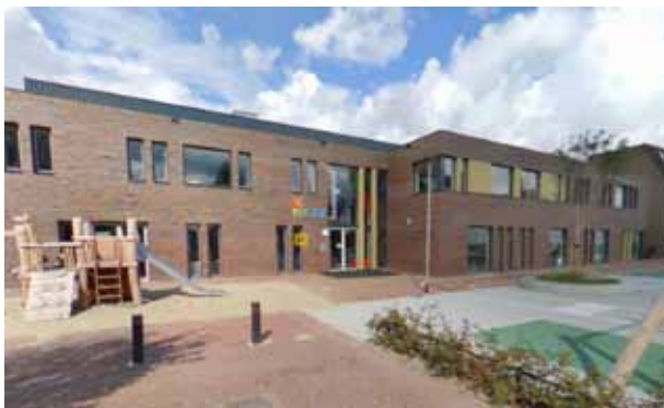
4. NIEUWBOUW BREDE SCHOOL DE VIOLIER
