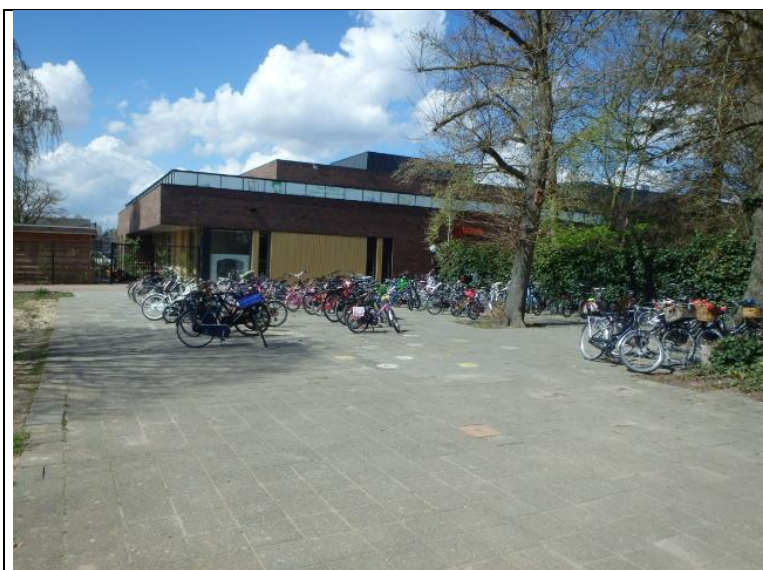
Foto 6: fietsenstalling op centrale deel deellocatie D (gezien vanuit het oosten, 12 april 2016)
