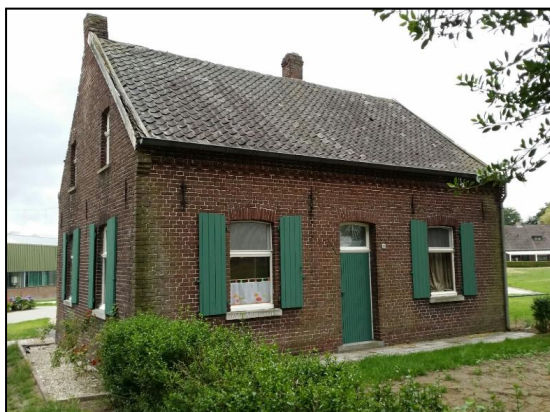
Foto bestaande situatie Roggelseweg 101 te Egchel
