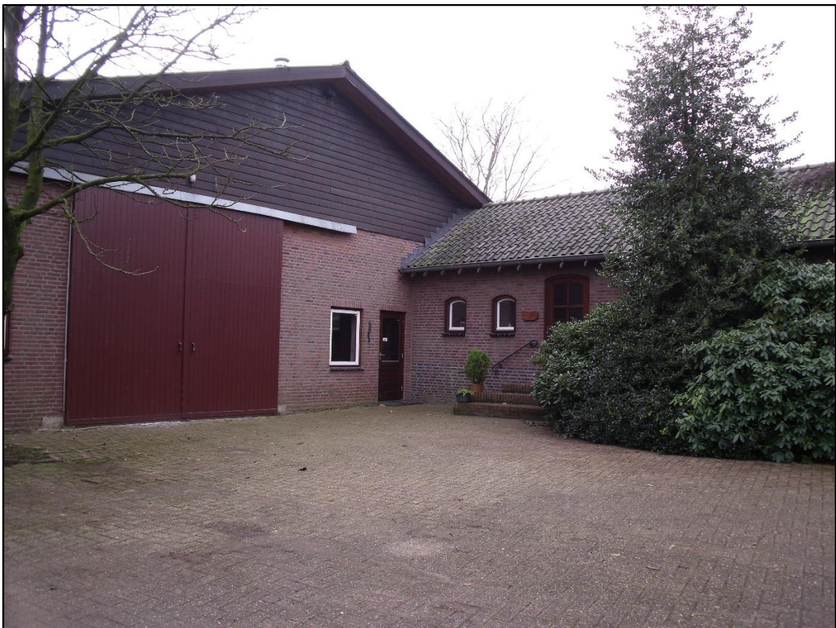
Afbeelding 14. Voorgevel loods Hert 6
