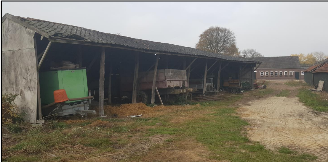
Afbeelding 8: impressie gesloopte bebouwing
