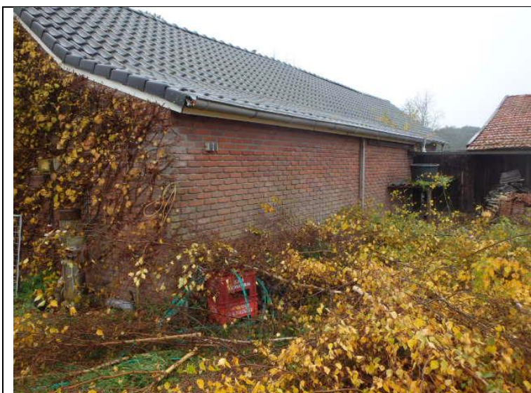
foto 5: standplaats voormalige bovengrondse rode dieseltank (gezien vanuit het noordoosten, 15 november 2017)
