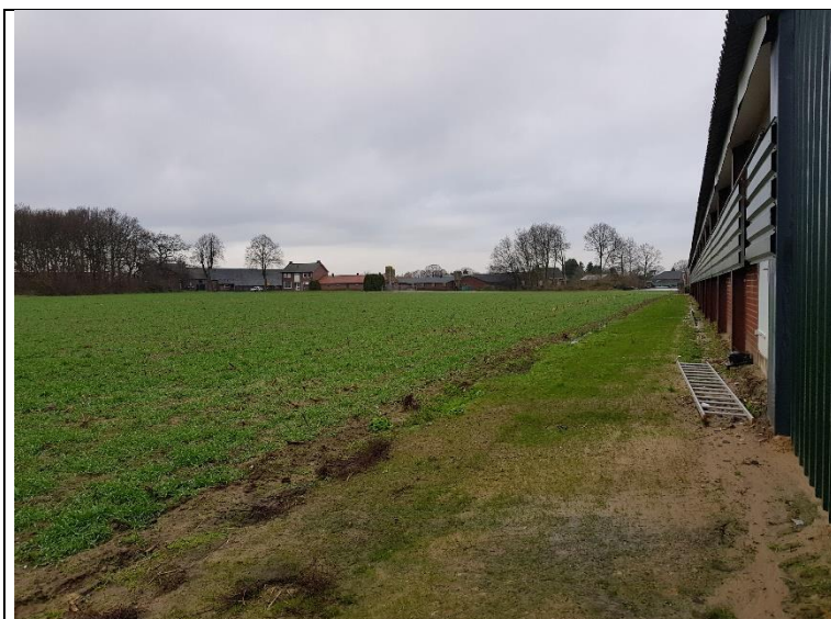
foto 4: westelijke uitbreiding (gezien vanuit het zuiden, 15 december 2015)
