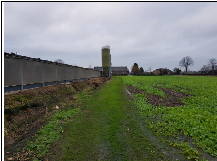
foto 2: oostelijke uitbreiding (gezien vanuit het zuiden, 15 december 2015)
