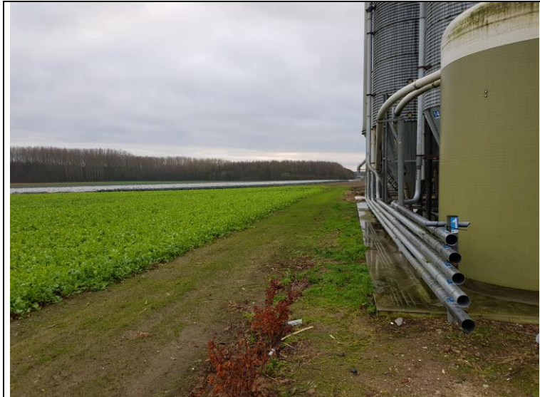
foto 1: oostelijke uitbreiding (gezien vanuit het noorden, 15 december 2015)
