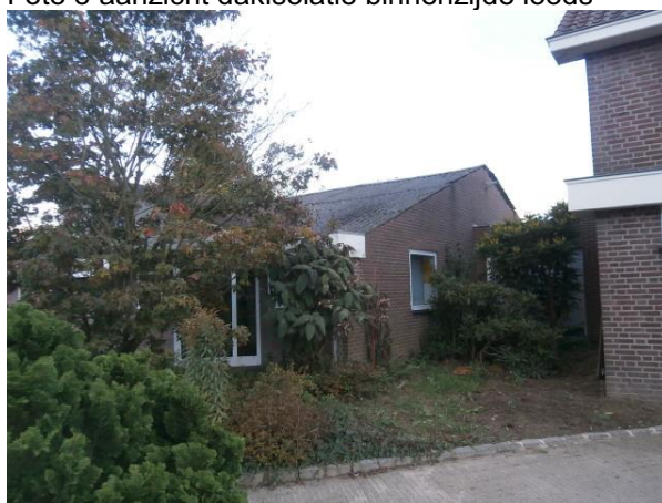
Foto 10 aanzicht voorgevel werkplaats/kantoor
