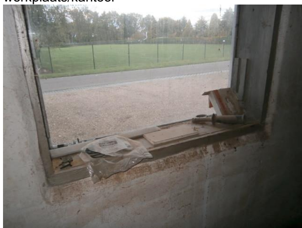
Foto 15 houten raamkozijnen werkplaats
