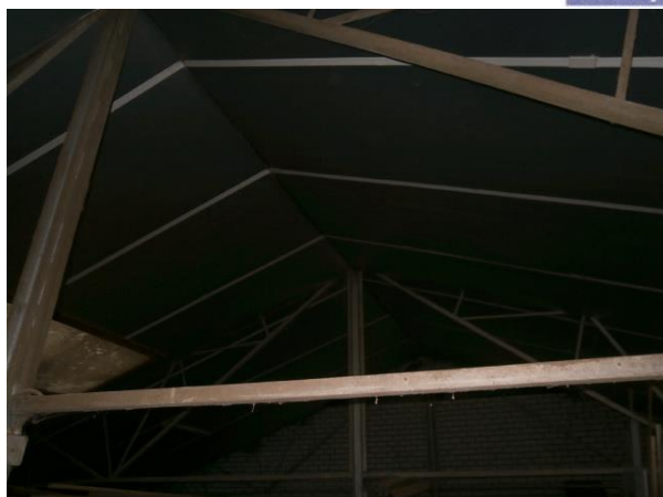
Foto 13 aanzicht dakisolatie binnenzijde werkplaats/kantoor
