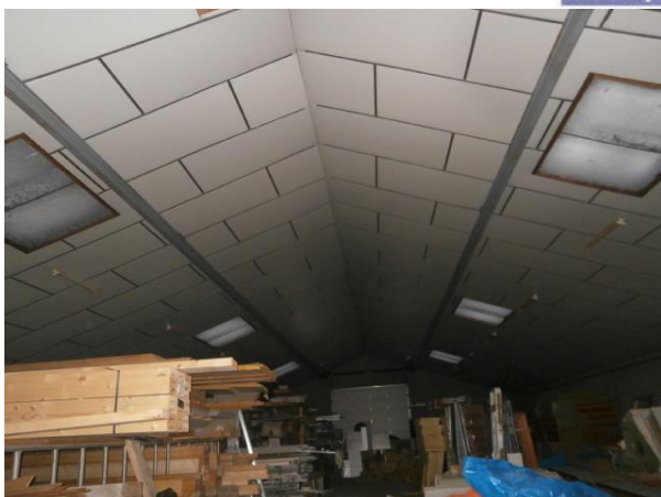
Foto 7 aanzicht dakisolatie binnenzijde loods
