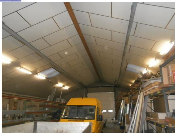
Foto 8 aanzicht dakisolatie binnenzijde loods
