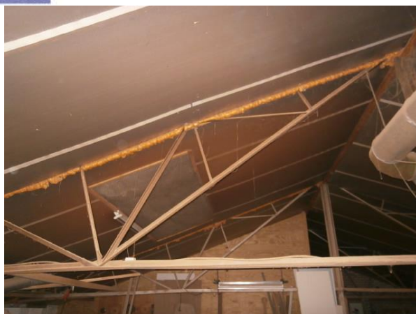
Foto 14 aanzicht dakisolatie binnenzijde werkplaats/kantoor
