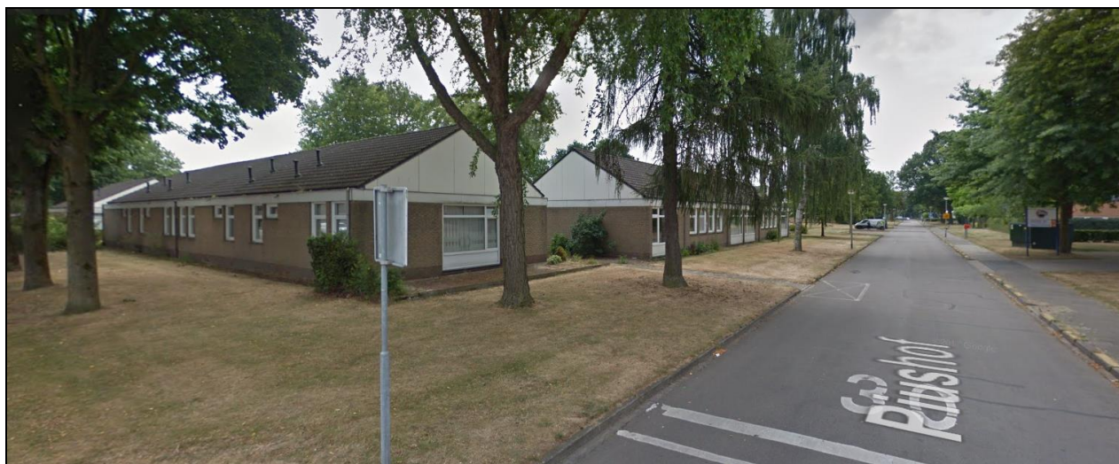
Figuur 5a: Zicht op de westzijde van het plangebied, gezien in zuidelijke richting (Bron: streetview Google Maps).
