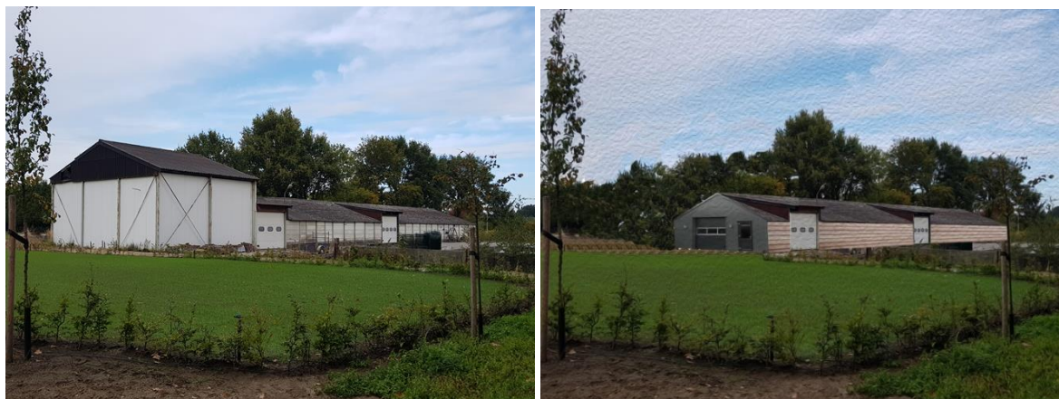
Loods, gelegen aan de Neerseweg 62, zoals deze momenteel eruit ziet & na renovatie.
