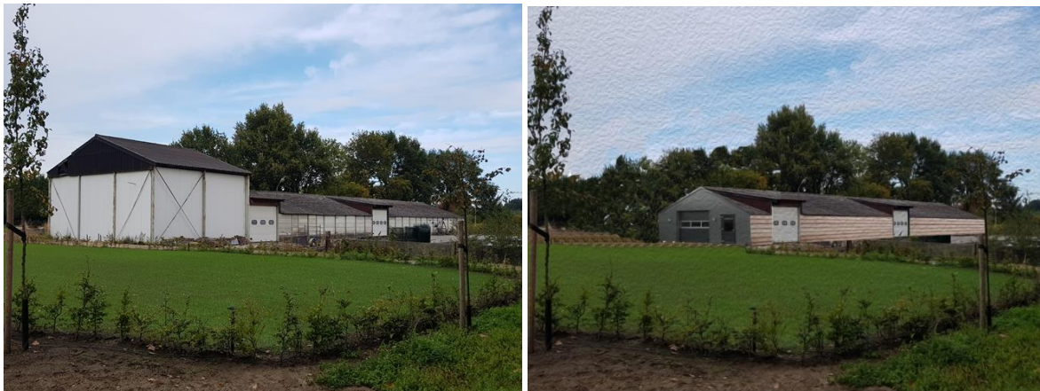
Loods, gelegen aan de Neerseweg 62, zoals deze momenteel eruit ziet & na renovatie.
