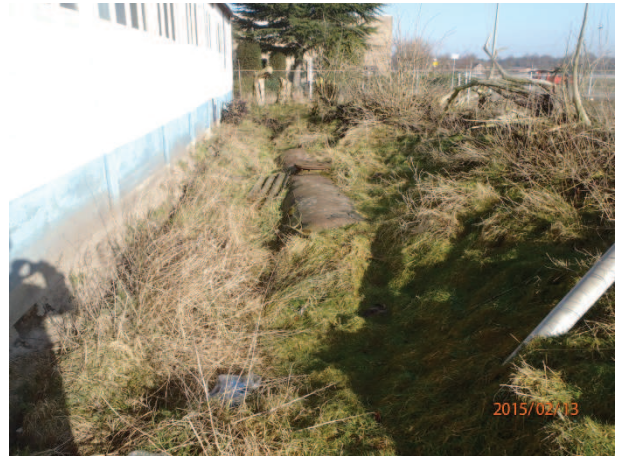
Foto 2: ondergrondse tank (14b).
