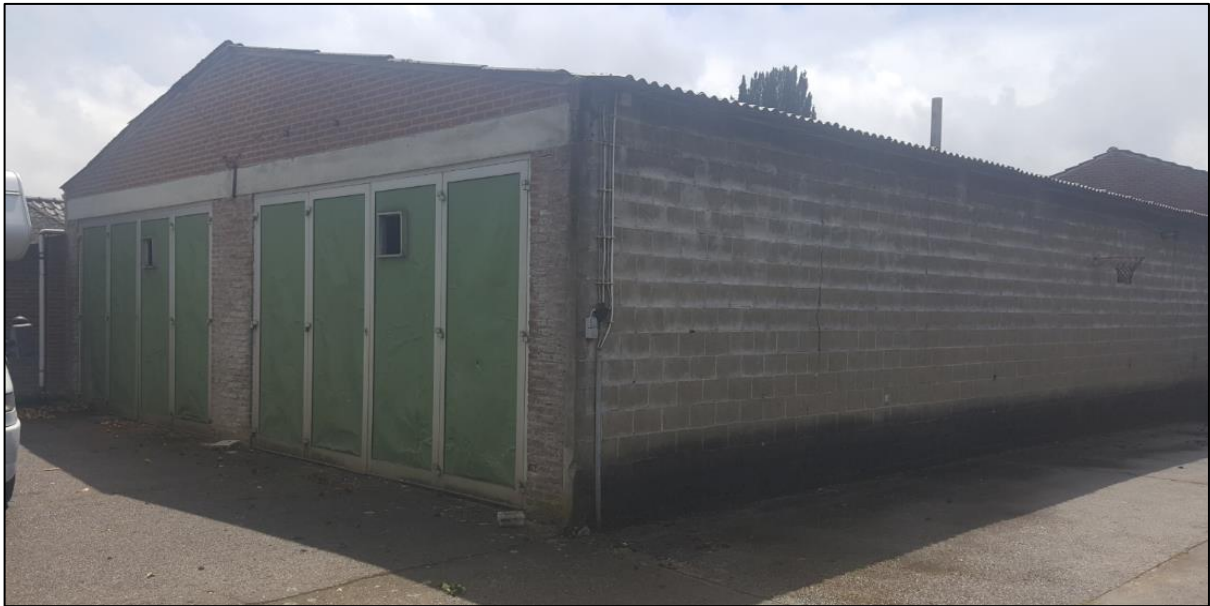
Afbeelding 7. Een van de voormalig bedrijfsgebouwen, dit gebouw wordt gedeeltelijk gesloopt en verder volledig gerenoveerd.
