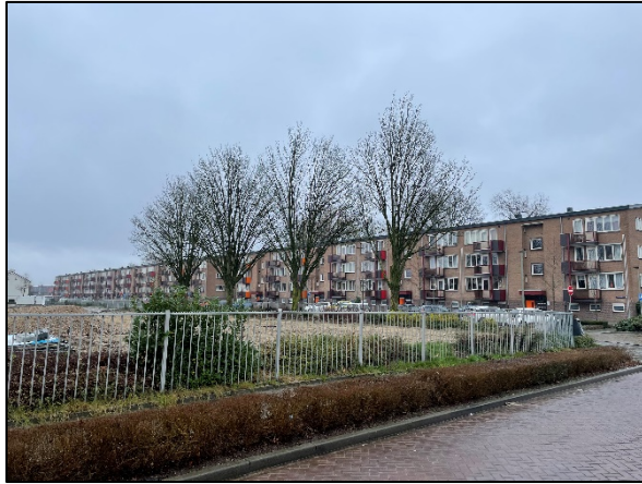
Afbeelding 9. Hoogbouw aan de Raadhuisstraat tegenover plangebied
