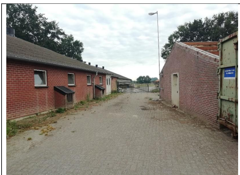
Foto 3: doorgang tussen de stallen (gezien vanuit het oosten, 14 augustus 2020)
