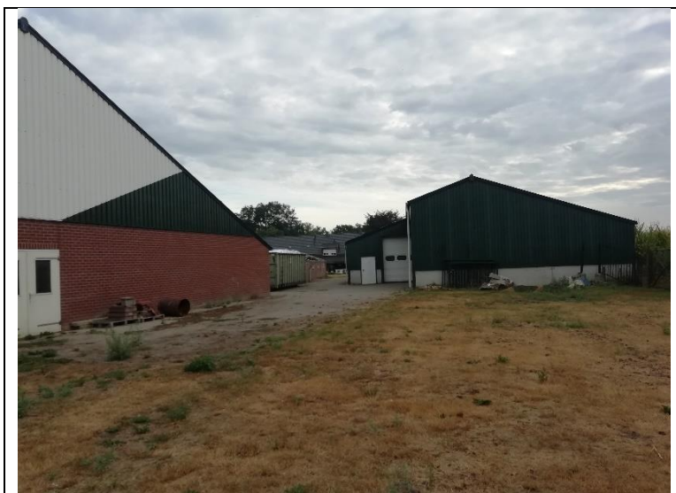
Foto 4: zuidzijde stallen (gezien vanuit het zuiden, 14 augustus 2020)
