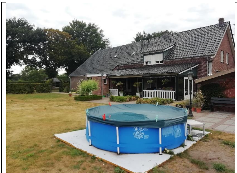
Foto 1: oostzijde woning (gezien vanuit het zuiden, 14 augustus 2020)
