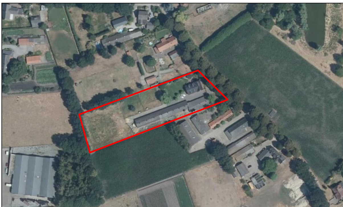
Luchtfoto huidige situatie Heihorst 16
