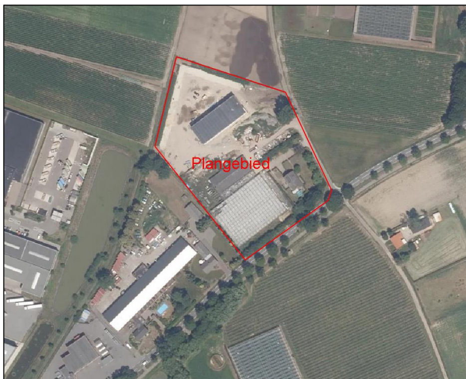
Luchtfoto met aanduiding plangebied en nieuw bedrijfsgebouw
