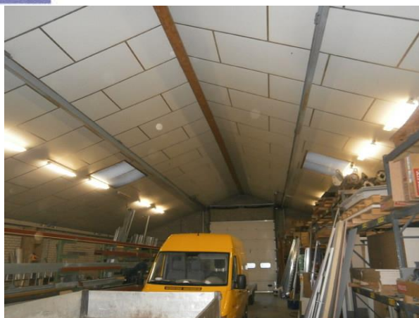
Foto 8 aanzicht dakisolatie binnenzijde loods
