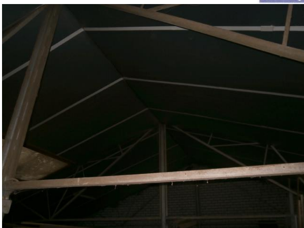
Foto 13 aanzicht dakisolatie binnenzijde werkplaats/kantoor
