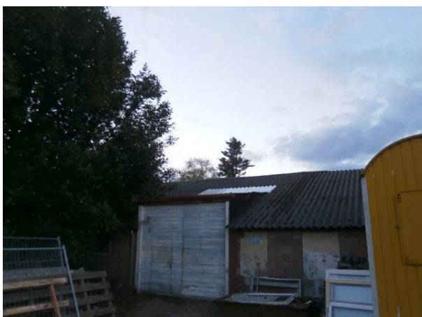
Foto 23 ac-nokstukken op deel werkplaats/kantoor
