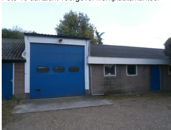
Foto 12 aanzicht linker zijgevel werkplaats/kantoor
