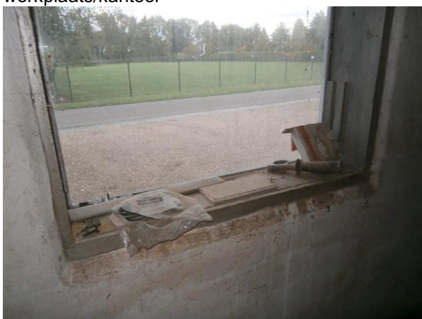
Foto 15 houten raamkozijnen werkplaats
