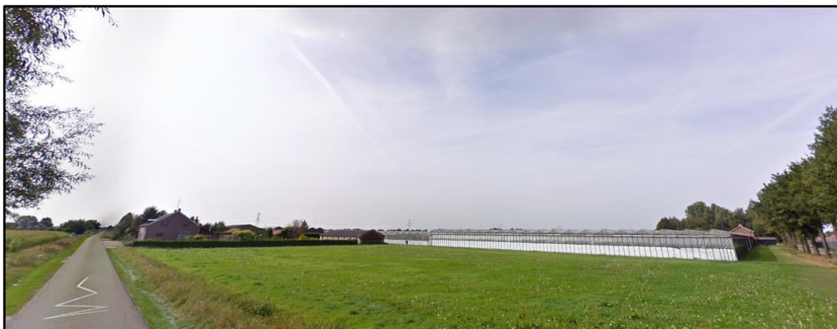
Afbeelding 3. Impressie huidige situatie van het plangebied (vanuit kruispunt Hub-Rootsdijk gezien)
