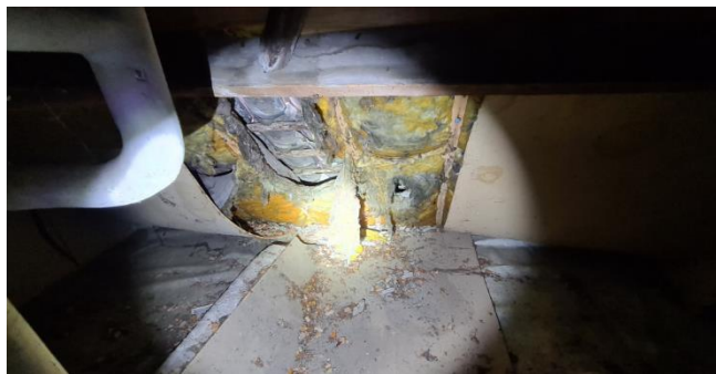
Figuur 8: Dak gezien vanaf de zolder
