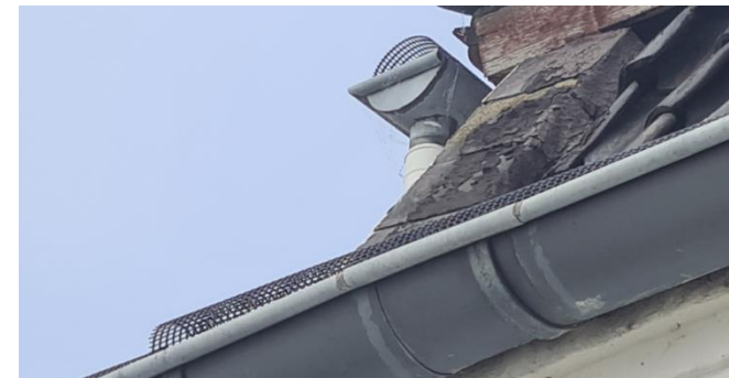
Figuur 11: Bladrooster in de regengoten van de woning
