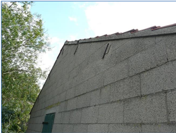
Foto 40 NO kopgevel gebouw 7
