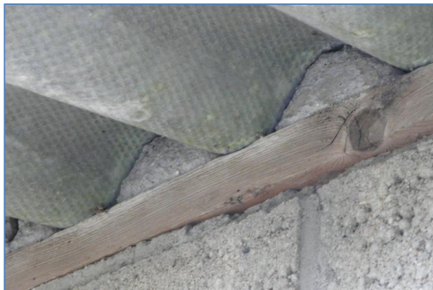
Foto 23 golfplaatafdichting gebouw 8
