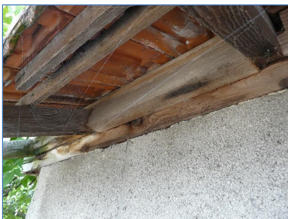
Foto 36 Afgedichte overgang muur en dak gebouw 4 Foto 37 open 'schone' zolder
