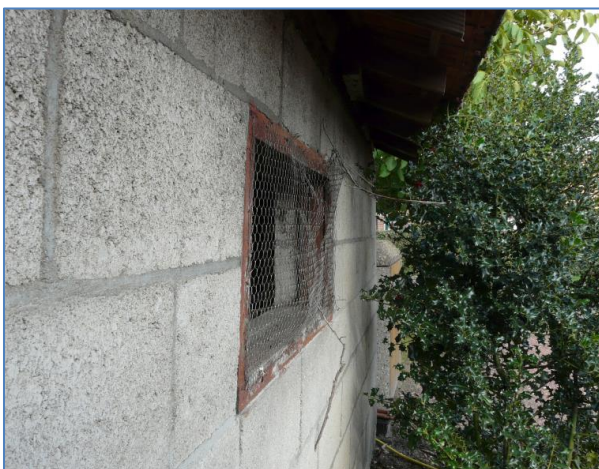
Foto 34 zijgevel met inlaatopening gebouw 4
