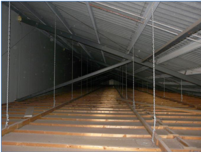
Foto 33 Open zolder naast luchtkanaal in gebouw 3
