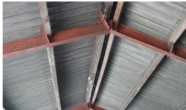
Foto 25 Gebouw 6: enkelwandig wand en dak en Foto 26 schone nok-onderkant
