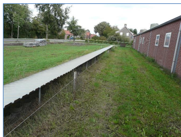
Foto 30 Kopgevel met beton en daarboven damwand met afdekstrips
