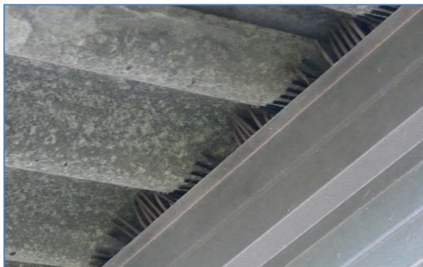
Foto 19 golfplaatafdichting gebouw 2
