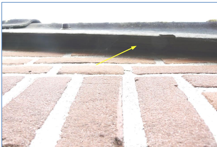
Foto 27 Plank achter windveren gebouw 1
