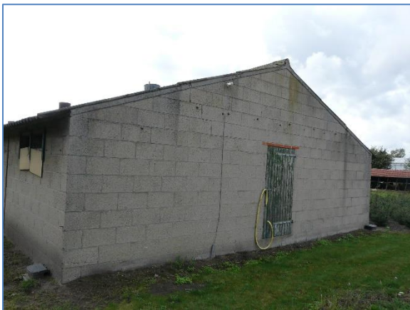
Foto 41 ZW gevel gebouw 8
