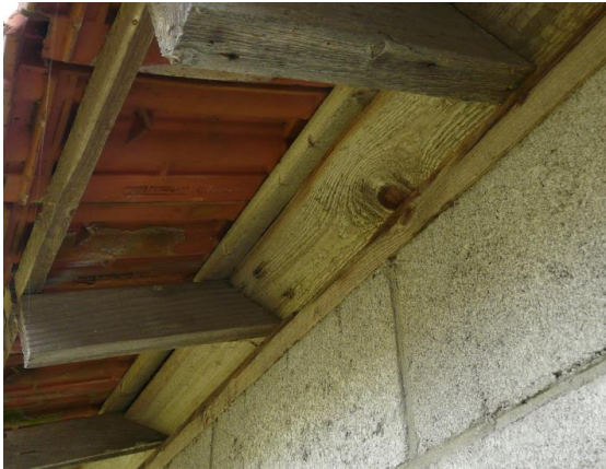
Foto 24 pannen afdichting gebouw 7 met hout en cement
