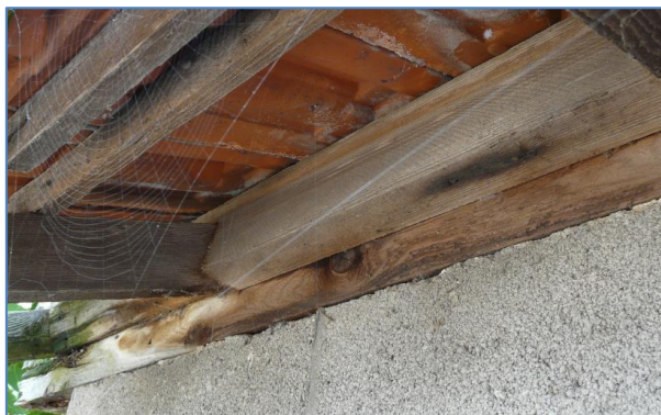
Foto 21 pannen afdichting gebouw 4 met hout en cement
