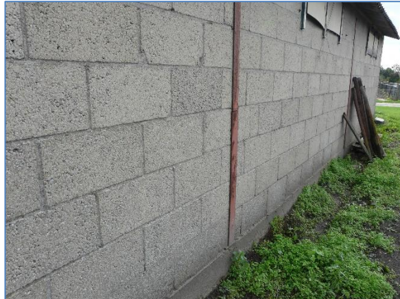
Foto 42 NW zijgevel gebouw 8
