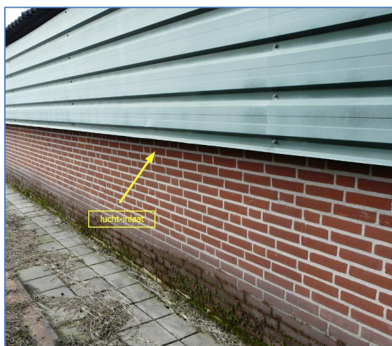
Foto 28 en 29 luchtinlaat zijgevels stallen 1 en 2
