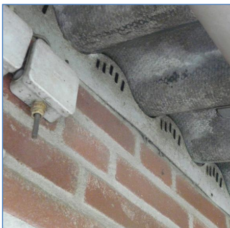
Foto 18 golfplaatafdichting gebouw 1
