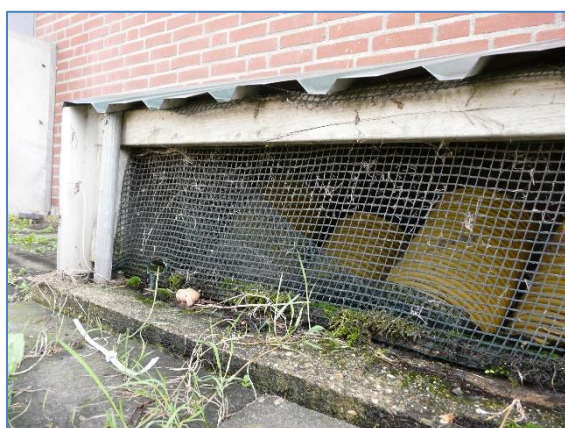
Foto 31 en 32 Overdekte inlaatzijde grondbuizen
