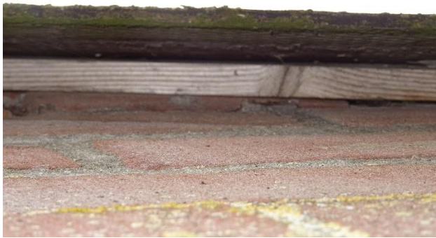
Afbeelding 20: aanwezige overstekken/ boeiboorden van de onderzijde afgesloten. Bron: [REDACTED]. Datum: 30-06-2021
