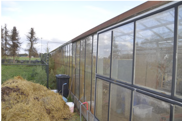
te slopen kas
