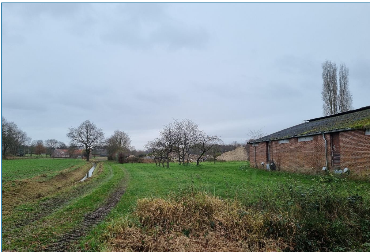
Figuur 2.4 Zicht op de Tasbeek, de groene terreininrichting met (fruit)bomen, de achtergevel van een bijgebouw en op het achterterrein de sloopresten ter plaatse van de voormalige agrarische bedrijfsgebouwen
