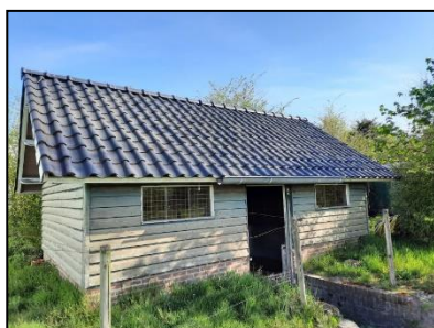
Figuur 4. Stal met dakpannen zadeldak, kijkrichting noord.
