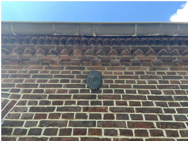
balkankers voorgevel voorzien van ornamenteel rozet; de getande uitkragende geprofileerde daklijsten
