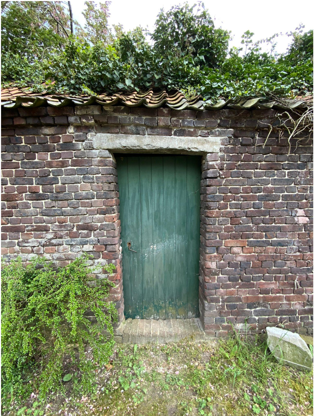
Foto 1: Bakhuisje met handgevormde veldovenstenen en handvormpannen, deels blauw gesmoord Foto 2: De bakoven, met in het stucwerk handtekeningen van ondergedoken engelse soldaten (nog niet gevonden door ons) Foto 3: Detail van de bovendorpel boven de deur van het bakhuisje
