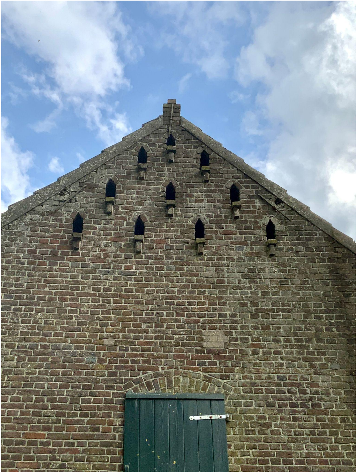
Foto 1: Achtergevel koeienstal met aangebouwde mest- en wagenschuur
