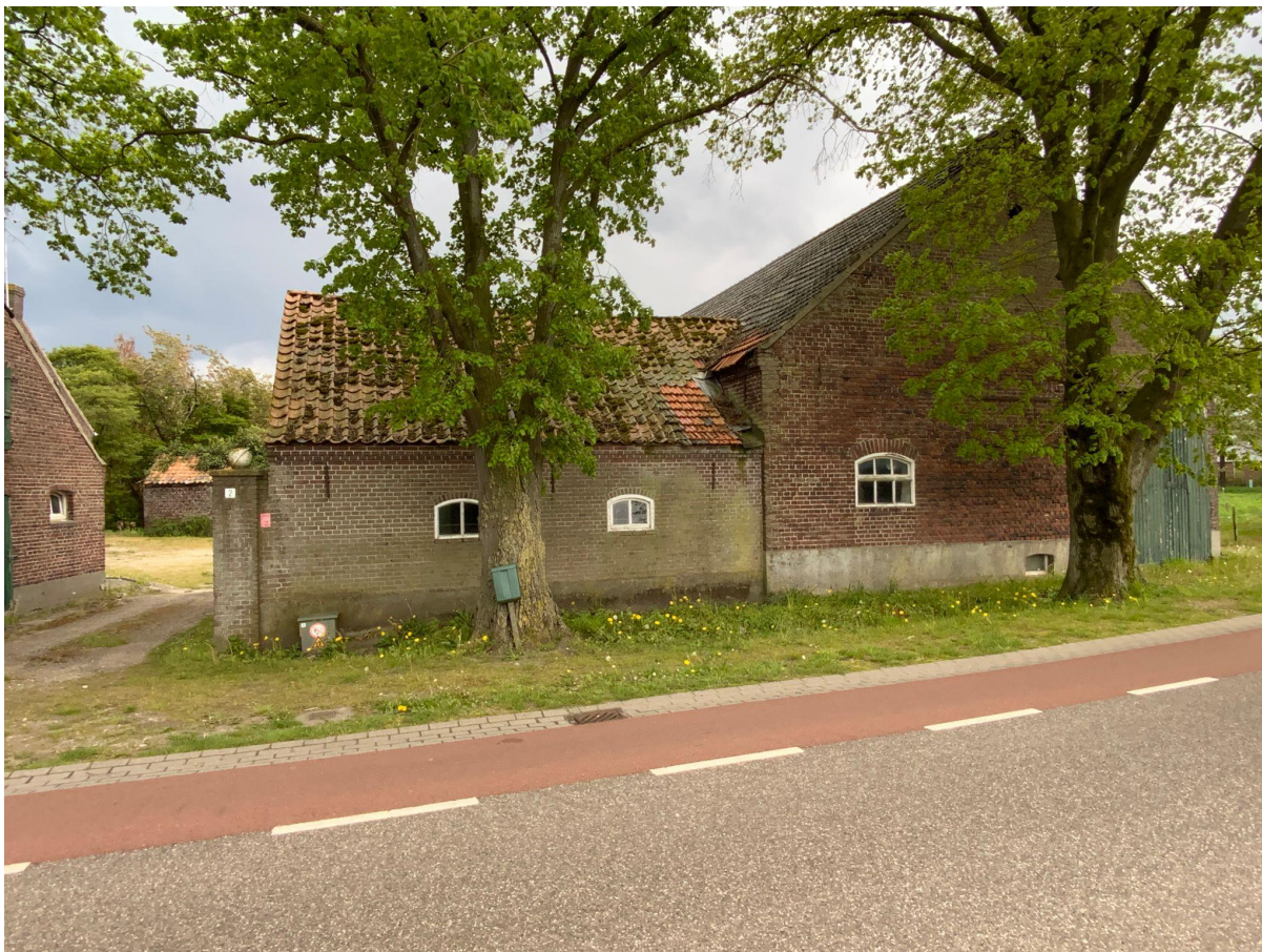
Foto 1: in 1974 nieuw gemetselde gevel varkensstal aan binnenplaats zijde
