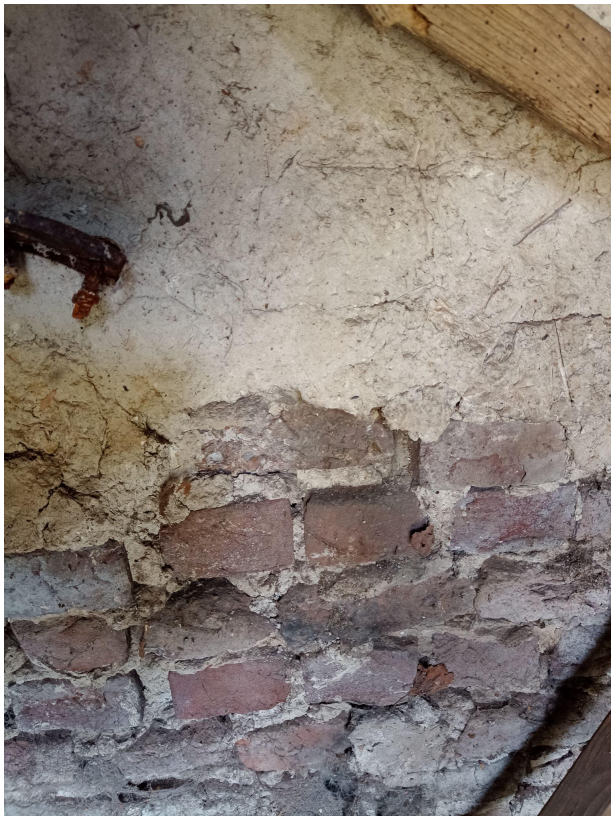
Staat kalkstuc binnenmuur bakhuisje
