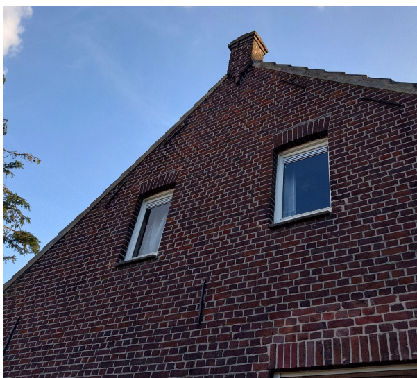
niet originele ramen NO gevel woonhuis
