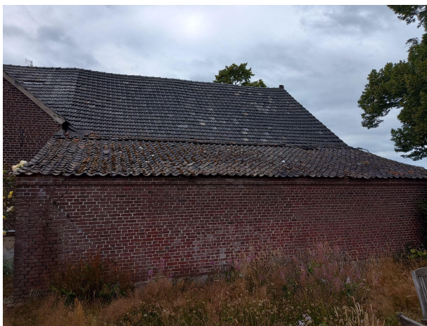
Dak van koeienstal en meststal
