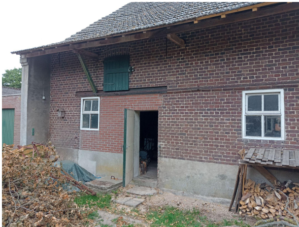
restanten schuifpoort gevel schuur binnenplaats Hergebruikte balken dakconstructie
