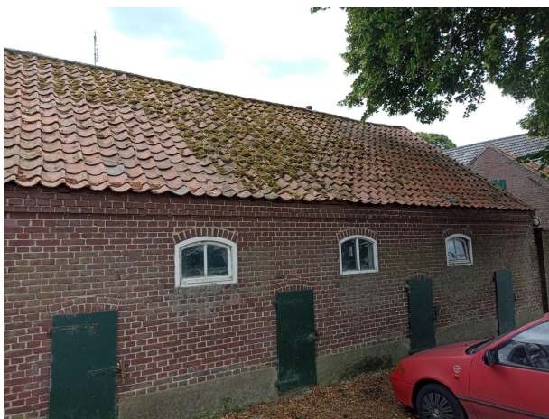
Varkensstal vanaf de Heezestraat Bouwkundige staat
