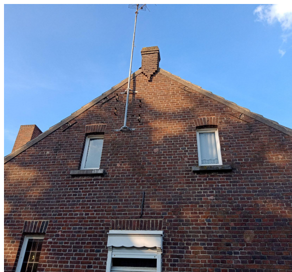
niet originele ramen ZW gevel woonhuis
