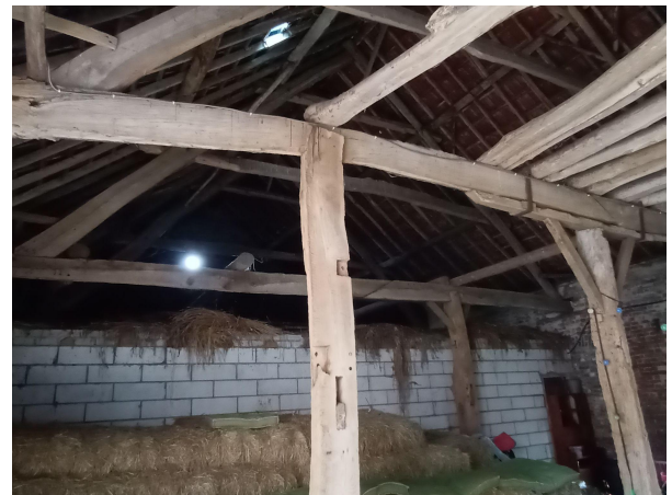
restanten schuifpoort gevel schuur binnenplaats Hergebruikte balken dakconstructie
