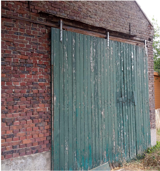
Poort en metselwerk grote schuur straatzijde
