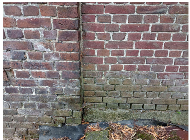
Metselwerk koeienstal straatzijde
