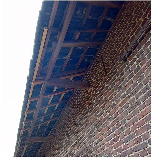
Herstelde overstek zijde binnenplaats
