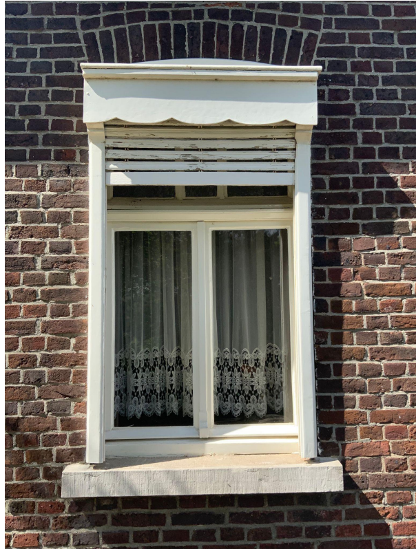
Raam woonhuis met houten zonwering
