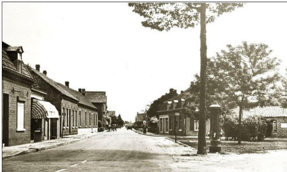
Afbeelding 3: beeld van de hoek Dorpstraat-Baarlosestraat in 1955 (bron foto: schumulder.nl)
