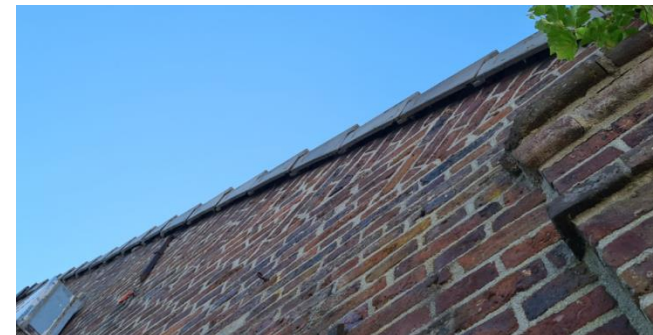
Figuur 5: Kierende dakrand bij de noordgevel van Baarlosestraat 7
