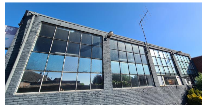
Figuur 9: Detailopname gevel Baarlosestraat 3
