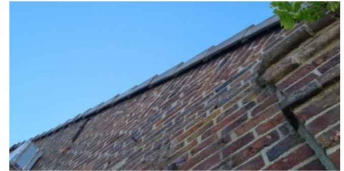
Figuur 5: Kierende dakrand bij de noordgevel van Baarlosestraat 7
