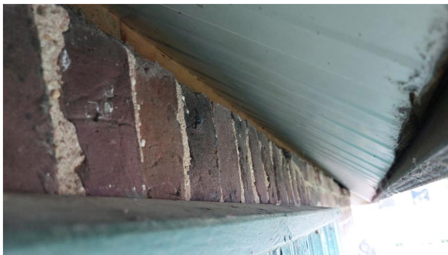
Figuur 4.2.1. Aanwezig spleten en openingen in de schuurtjes (hierboven=stenen schuurtje) waren tijdens het veldbezoek goed te inspecteren. Vleermuizen en vleermuisuitwerpselen zijn afwezig.
