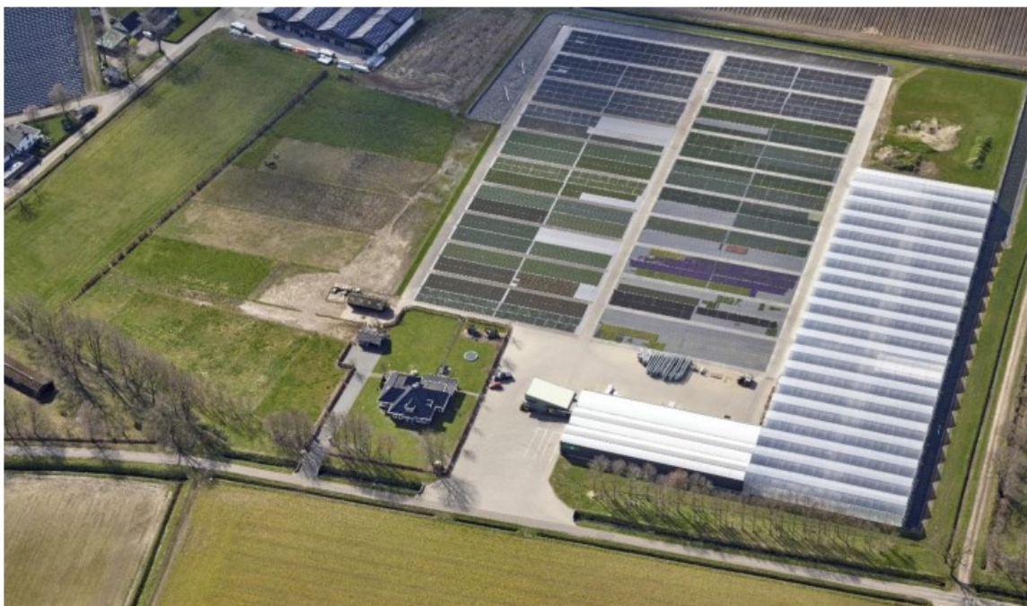
Vogelvluchtfoto kijkend richting het zuiden
