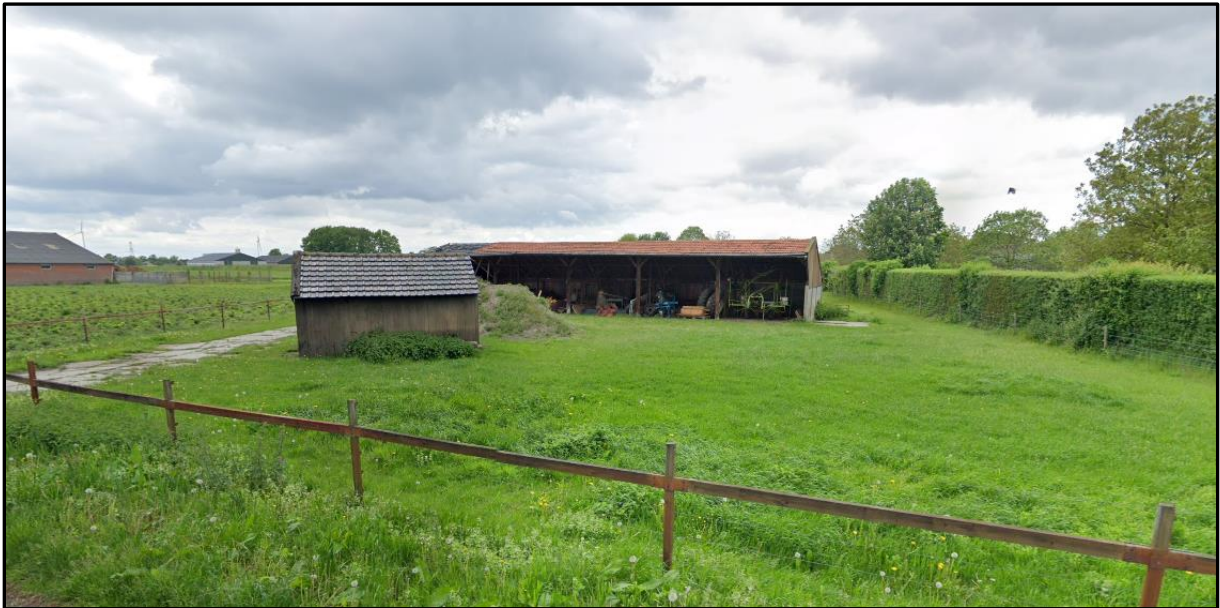
Afbeelding: aanwezige bebouwing die gesloopt zal worden.
