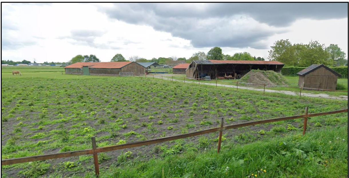
Afbeelding: aanwezige bebouwing die gesloopt zal worden.
