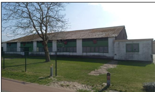
Afbeelding 22: reeds gesloopt bedrijfsgebouw
