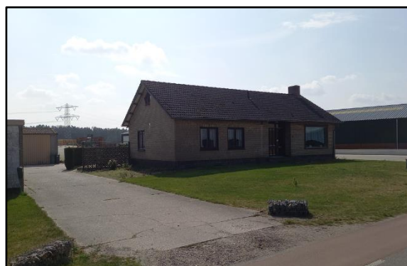
Afbeelding 23: op termijn te slopen woning
