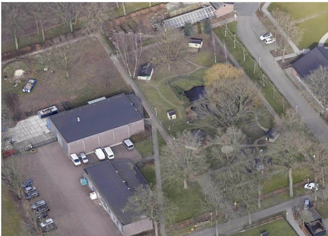
Het onderhoudsgebouw met het buitenterrein 'boerderij' (noordwestelijk gedeelte)
