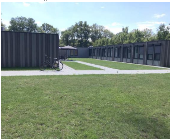
Afbeelding 18. Deelgebied 3, de semipermanente appartementen in de noordhoek van deelgebied 3.
