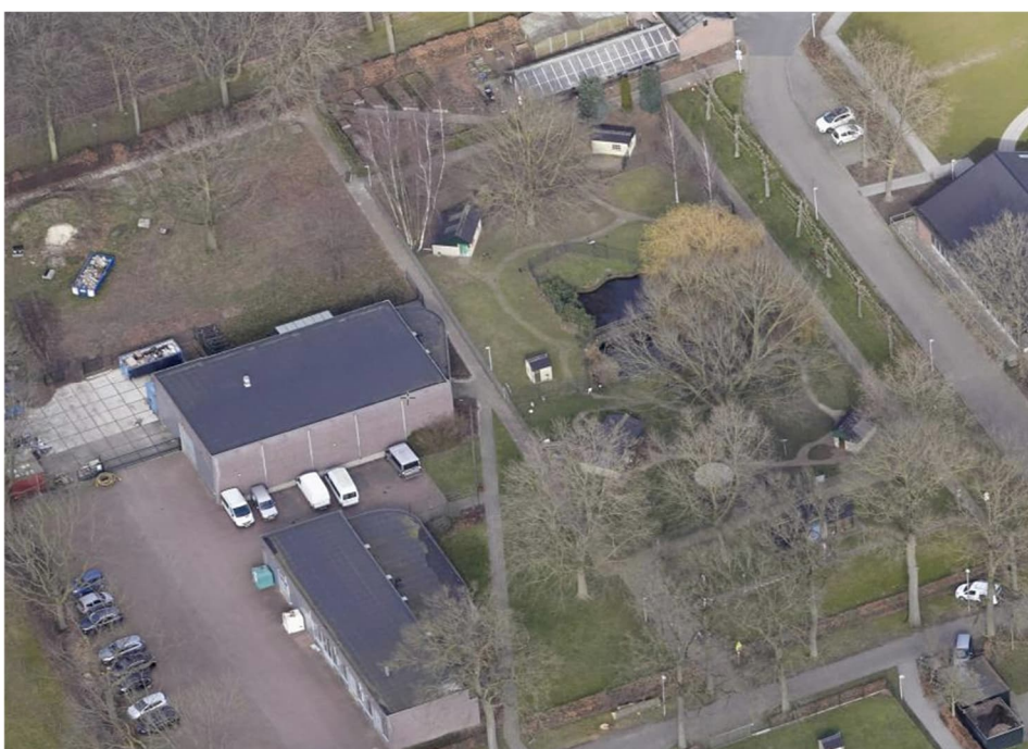
Het onderhoudsgebouw met het buitenterrein 'boerderij' (noordwestelijk gedeelte)
