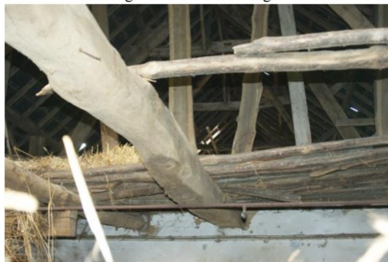
36 Stal aan woning balken begane grond
