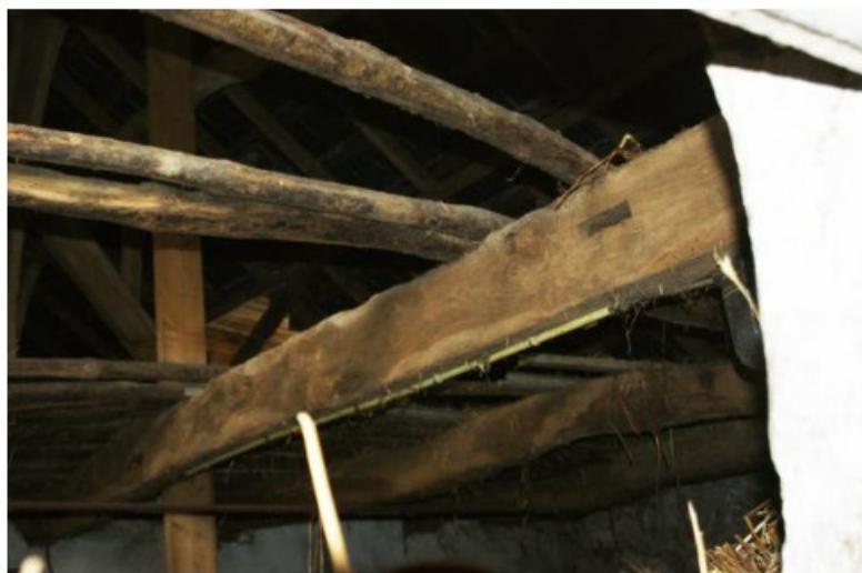
37 Stal aan woning balken begane grond
