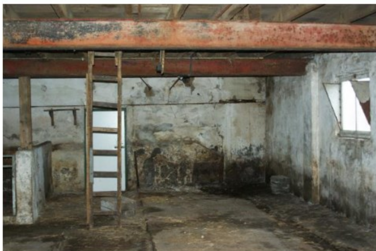
33 Stal aan woning begane grond
