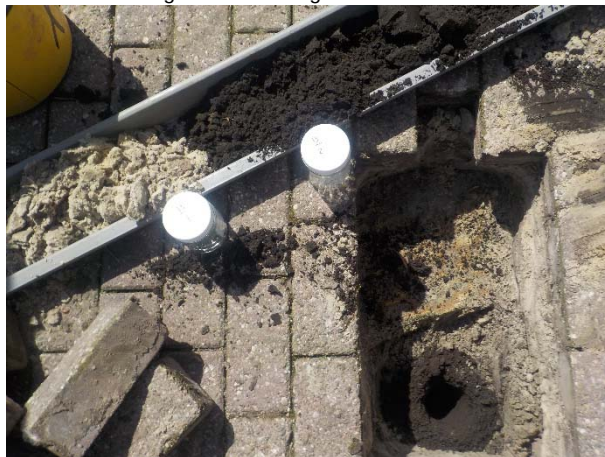
Foto 22. Proefgat met boring 13
