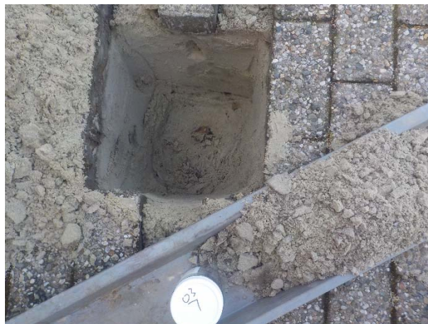
Foto 18. Proefgat met boring 3
