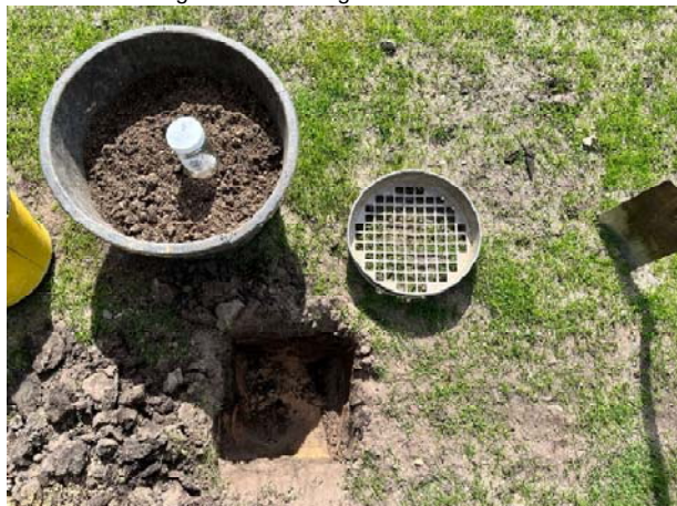
Foto 23. Proefgat met boring 16
