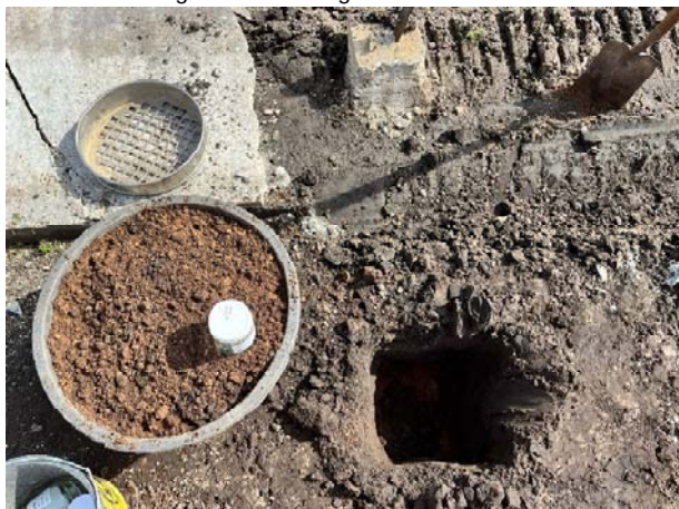
Foto 29. Proefgat met boring 23
