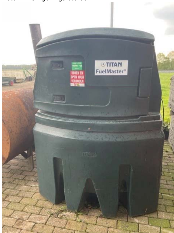
Foto 46. Dieseltank bovengronds, nieuwe locatie
