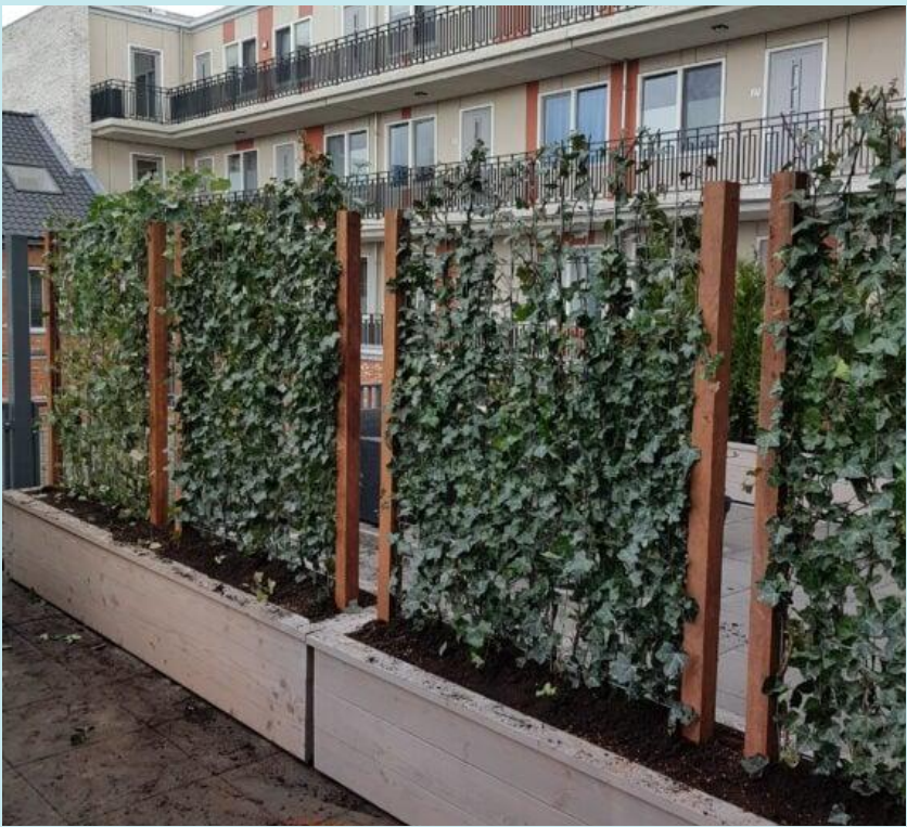
Klimplanten in plantenbakken zorgen voor afscheiding tussen buitenruimtes en onttrekken de installaties uit het zicht
