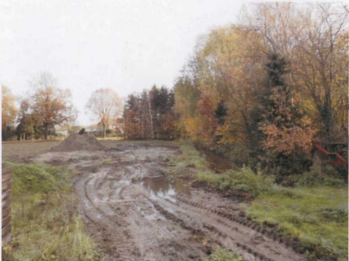
foto 1: akkerland en infiltratiebassin
