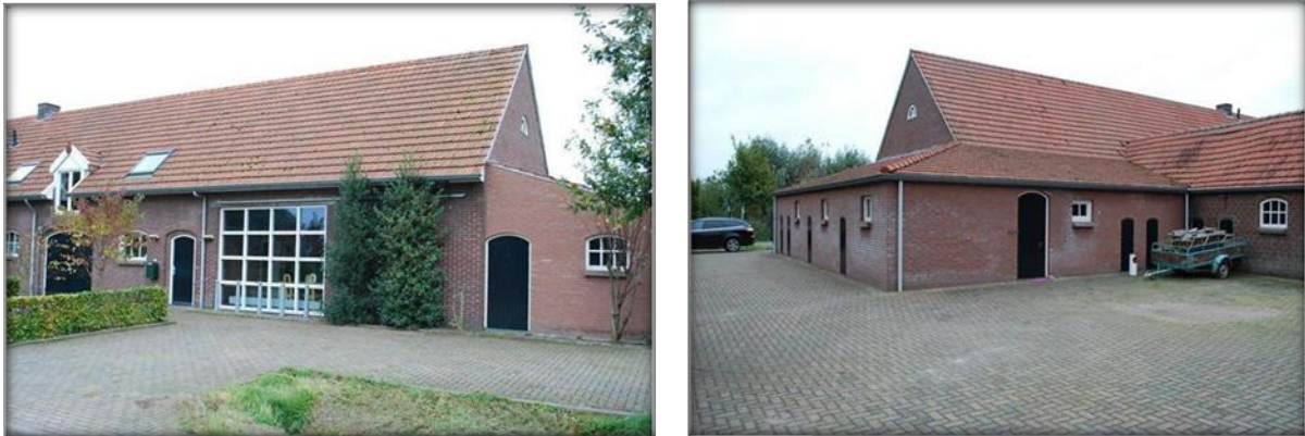
Figuur 4 Voor- en achterzijde woning aan de Baarloseweg 3a te Helden
