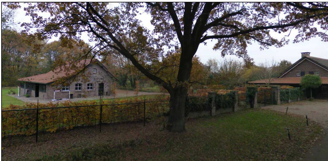
Figuur 4. Bestaand bijgebouw Laar 3a (links) bij de woning (rechts). Bron: Google Maps
