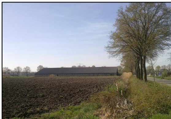
Afbeelding 7. Bedrijf gezien vanuit oostzijde
