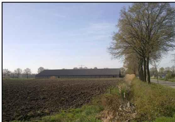
Afbeelding 7. Bedrijf gezien vanuit oostzijde
