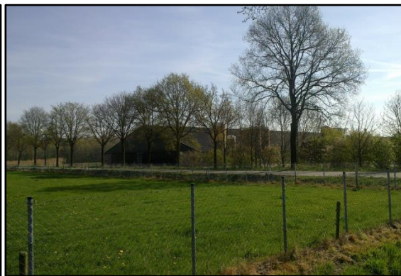
Afbeelding 8: bedrijf vanuit noordzijde gezien (Melkweg)
