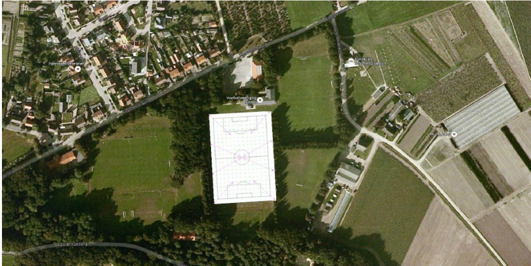
Figuur 5: plaatsing lichtmasten rond het voetbalveld
