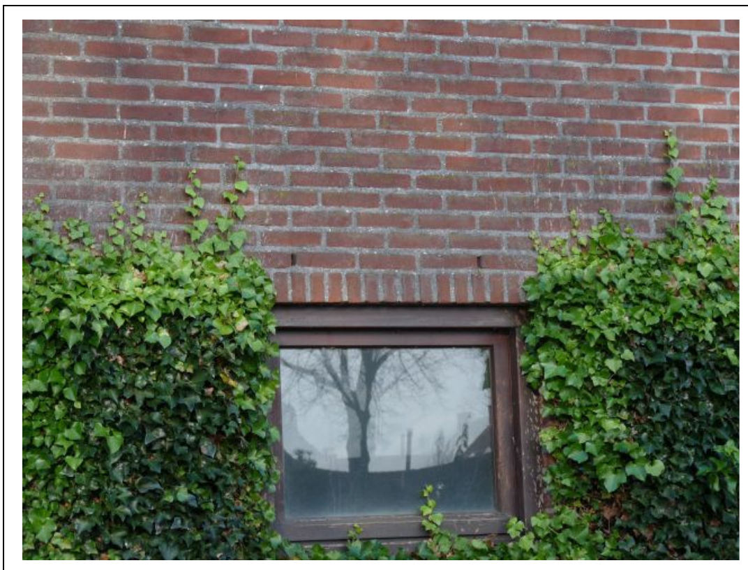
Foto 4. Spouwstenen en klimop aan de varkensschuur.
