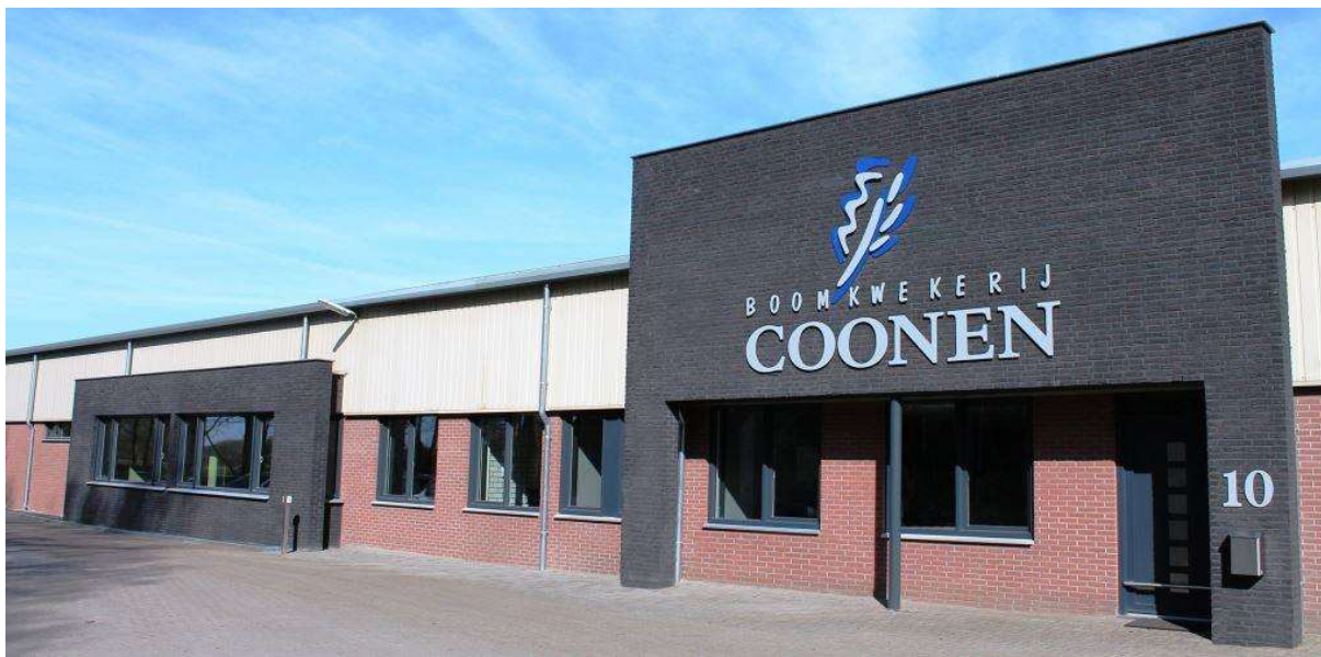
Aanzicht bestaande bebouwing
